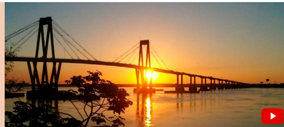
Corrientes- Chaco. Puente General Belgrano.
