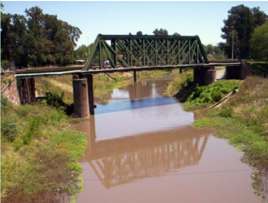
Paso del Rey. Puente del FFCC Sarmiento.
