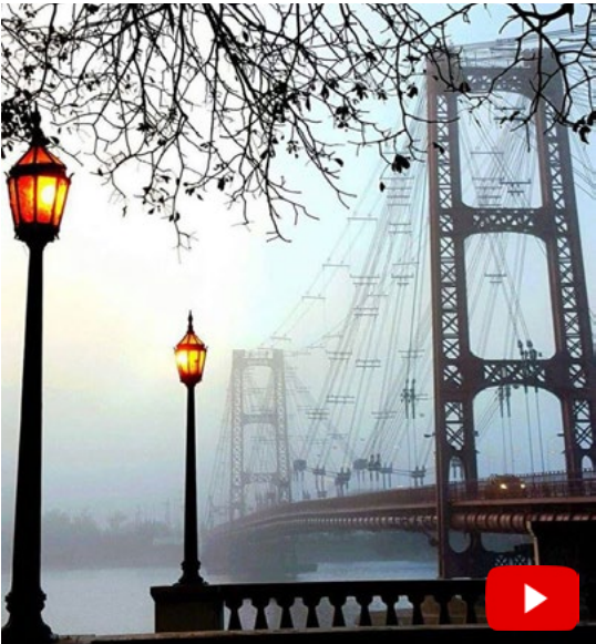
Santa Fe. Puente colgante.
