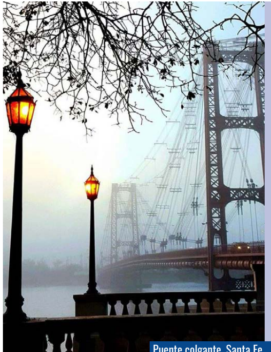
Puente colgante, Santa Fe.
